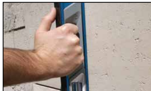
Use un nivel grande para verificar y mantener un plano de cara uniforme sobre distintas losetas.
